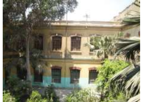
اللوحة رقم (٥) الواجهة الشرقية
