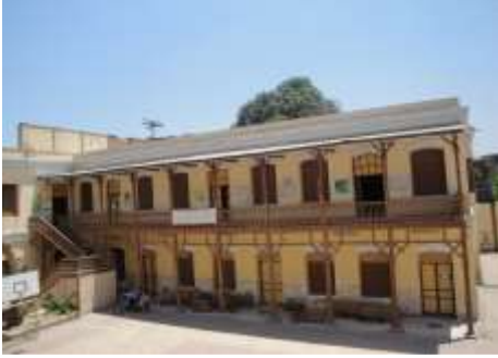
٨- الواجهة الغربية بالمبنى الثاني من الواجهة الشرقية بالمبنى الثاني
